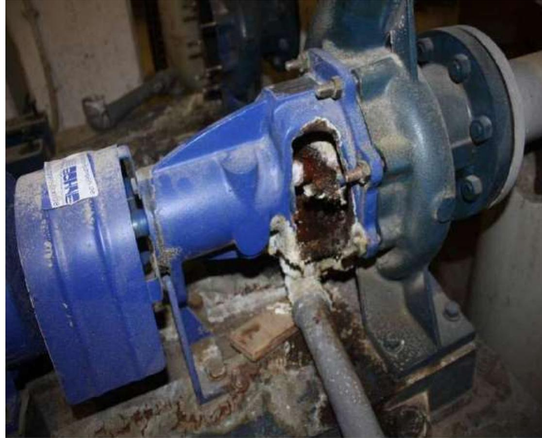
Abbildung Leckagen: **Wasseraustritt an Gleitringdichtung sowie massive Salzkrusten.**
