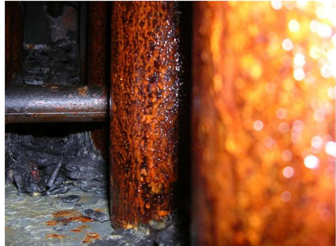
Abbildung Rauchgasrohre: Auswirkungen von mangelhafter Heiznetzwasserqualität in einem Wärmeerzeuger: Erosion, Korrosion und Ablagerungen von Kalk und Magnetit. **Folgen sind sinkende Wirkungsgrade sowie Leckagen durch Spannungsrisse.**
